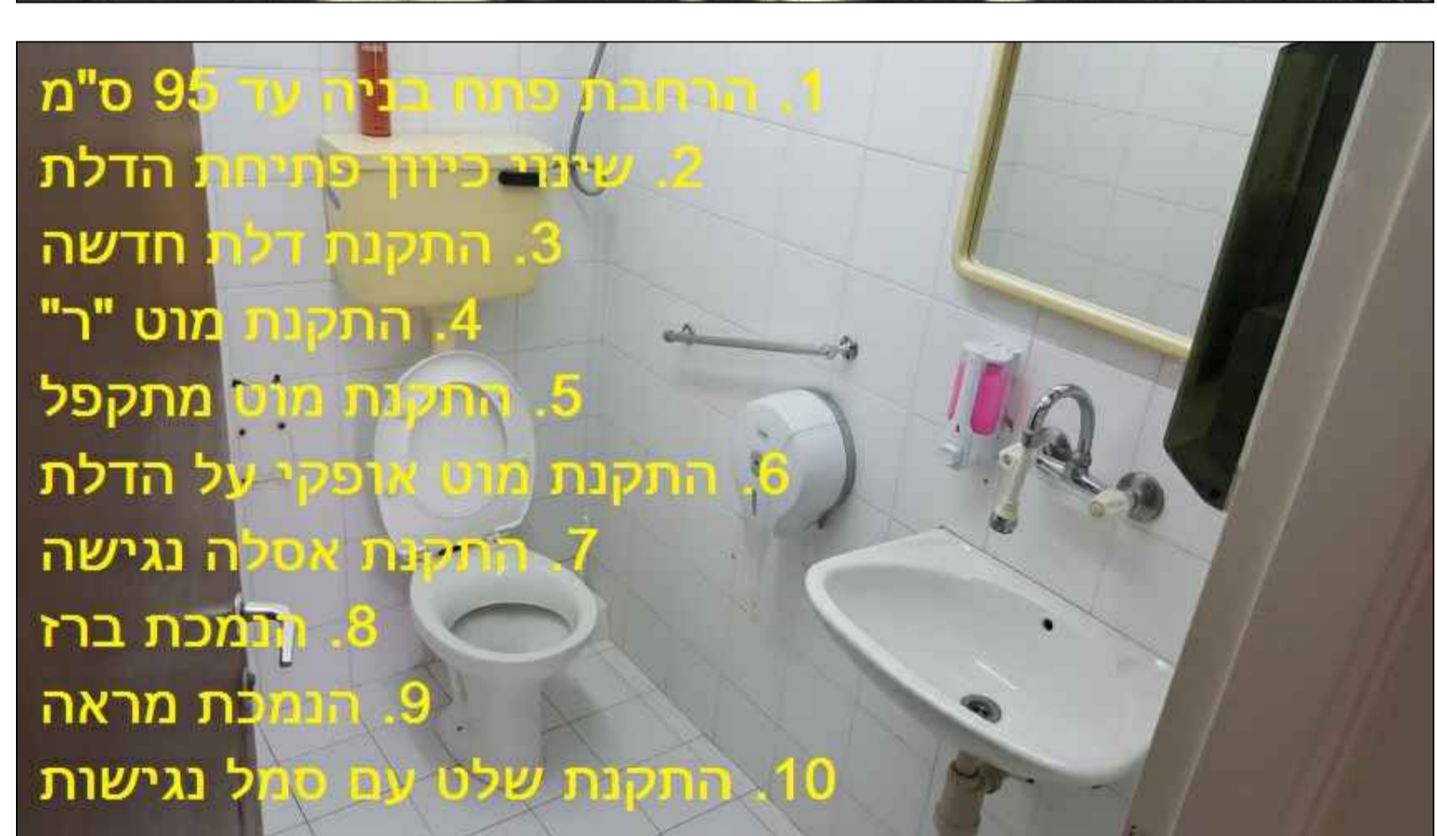
תיקונים בשביל בטון אורך 3 מ' 1. הרחבת פתח בניה עד 95 ס"מ 2. שינוי כיוון פתיחת הדלת 3. התקנת דלת חדשה 4. התקנת מוט "ר" 5. התקנת מוט מתקפל 6. התקנת מוט אופקי על הדלת 7. התקנת אסלה נגישה 8. הנמכת ברז 9. הנמכת מראה 10. התקנת שלט עם סמל נגישות
