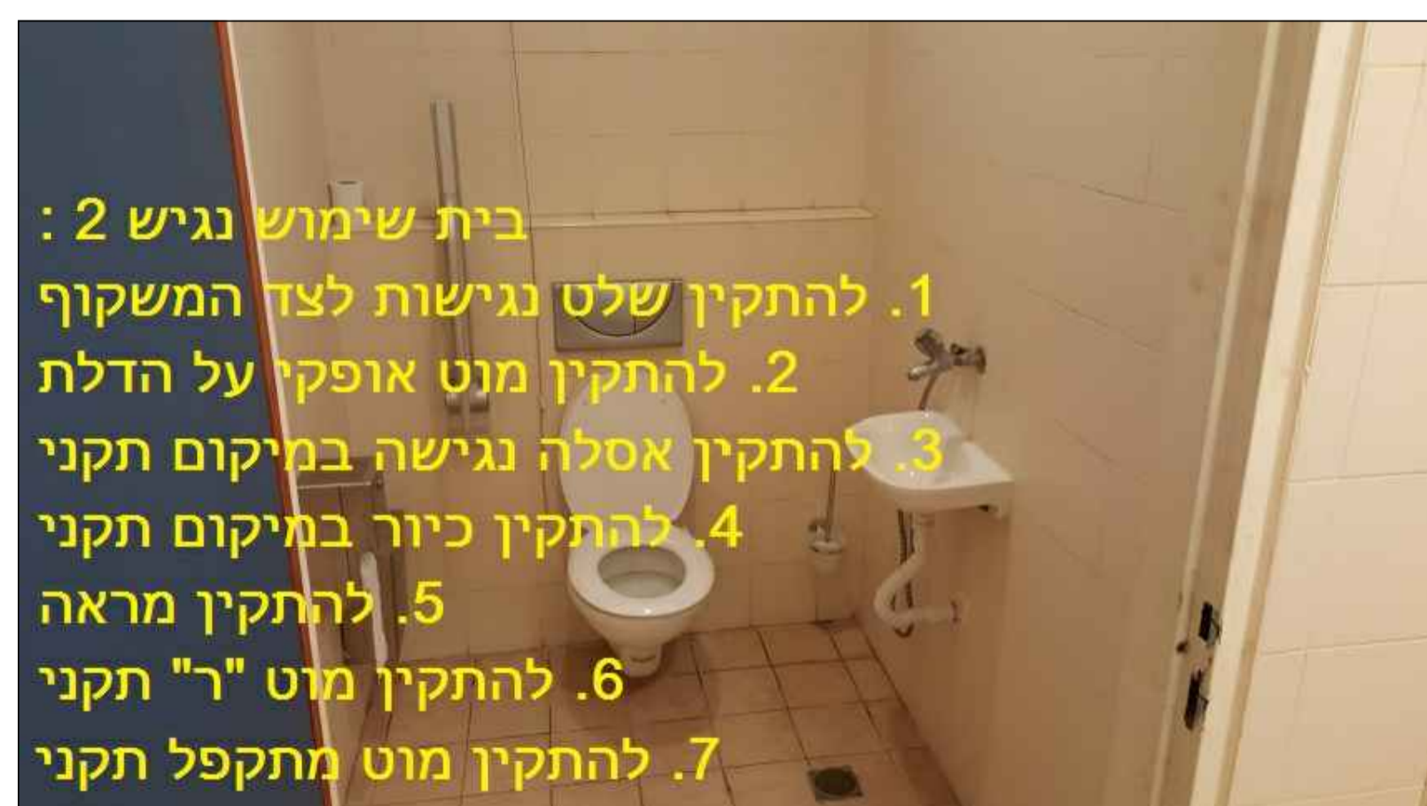
בית שימוש נגיש 2 : 1. להתקין שלט נגישות לצד המשקוף 2. להתקין מוט אופקי על הדלת 3. להתקין אסלה נגישה במיקום תקני 4. להתקין כיור במיקום תקני 5. להתקין מראה 6. להתקין מוט "ר" תקני 7. להתקין מוט מתקפל תקני
