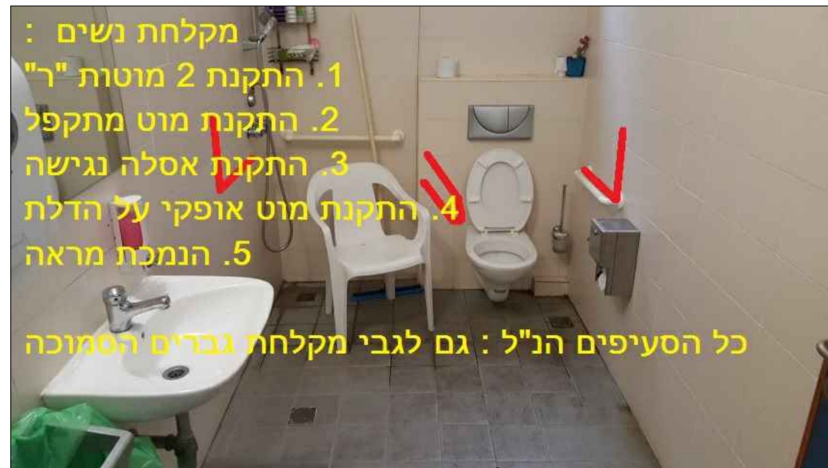
מקלחת נשים : 1. התקנת 2 מוטות "ר" 2. התקנת מוט מתקפל 3. התקנת אסלה נגישה 4. התקנת מוט אופקי על הדלת 5. הנמכת מראה כל הסעיפים הנ"ל : גם לגבי מקלחת גברים הסמוכה
